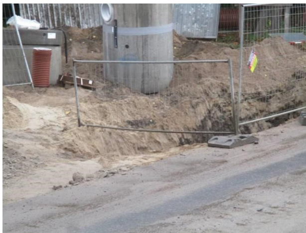
Przyczyny ujawnianych nieprawidłowości
